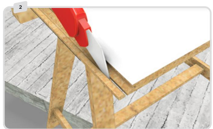
Nach dem Einbau der ersten Platte schneiden Sie ein Stück der Nut der 2. Platte ab.
