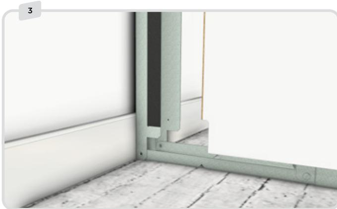
Schneiden Sie in die Platte einen Ausschnitt für die Sockelleiste.
