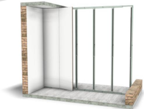
Haken Sie die 2. Platte in einem Winkel von 30° in die erste ein. Bewegen Sie die Platte vor und zurück, bis sie einrastet.
